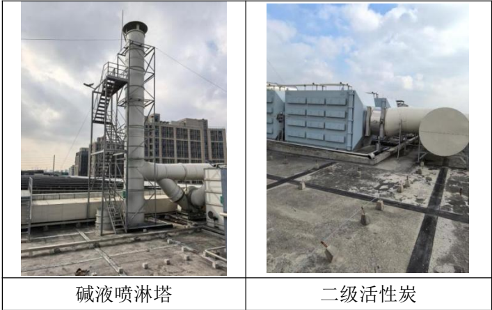
图 2-13 本项目依托现有项目废气处理设施
