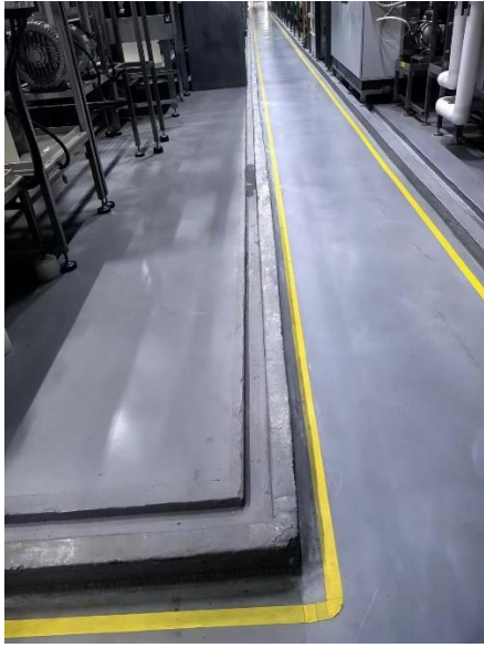
现有项目生产线围堰、地面防渗
